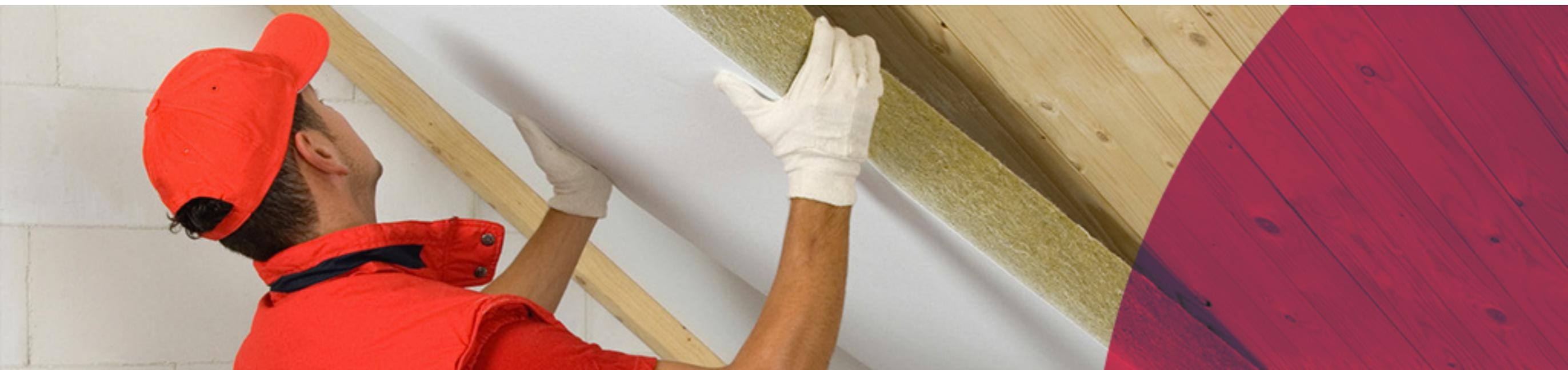
Os materiais em fibras minerais de lã de rocha são muito utilizados em setores industriais como refinarias, petroquímicas, indústria cerâmica e até na geração de energia elétrica, nos quais os produtos Biolã são aplicados em isolamento térmico de caldeiras, por exemplo. Além da indústria pesada, a lã de rocha também é utilizada na Construção Civil, como isolante acústico em cinemas, casas de show e teatros.
