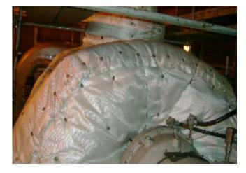
Materiais: A Jaqueta Térmica Removível, da IBAR, é fabricada com tecidos isolantes que envolvem a manta de fibra cerâmica ou de lã de rocha. Todos os materiais utilizados possuem laudo técnico de certificação.
